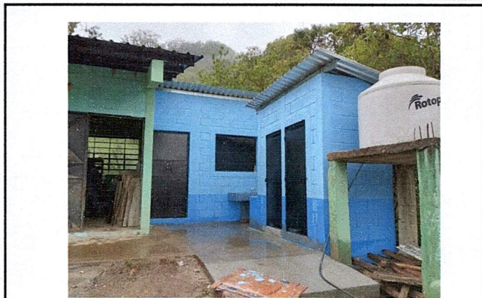
Foto 2: finalizada con pintura
